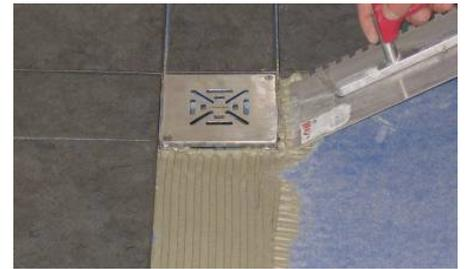
**3** Fliesenkleber auf die Auflagestellen mit einer Zahnkelle auftragen. Den Rahmen fest in das Kleberbett eindrücken und ausrichten. Fliesen in das frische Kleberbett einlegen.
