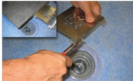
**2** Die Anker von BLANKE RENOROST auf die gewünschte Fliesenstärke mit einer Spitzzange umknicken (Einrastungen für 4 mm/8 mm/10 mm und höher).
